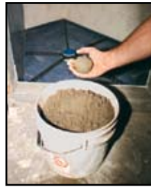
Llénelo con mezcla de cemento y arena
